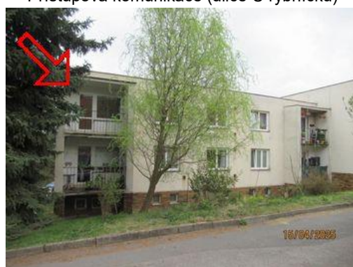
Bytový dům - pohled SZ
