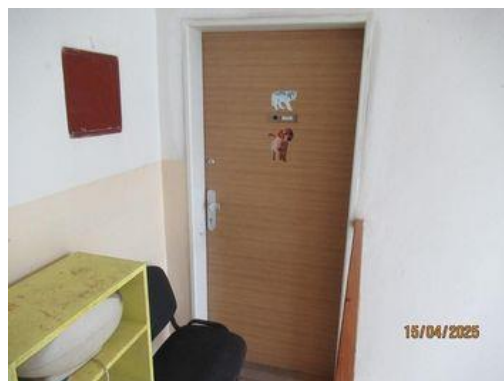
Vstup do bytu
