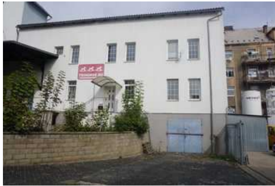
pohled na východní část objektu
