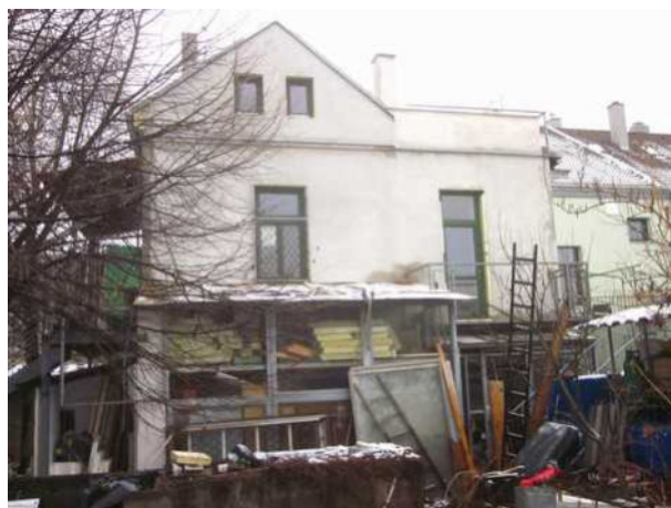
pohled na část BD s oceňovaným bytem
