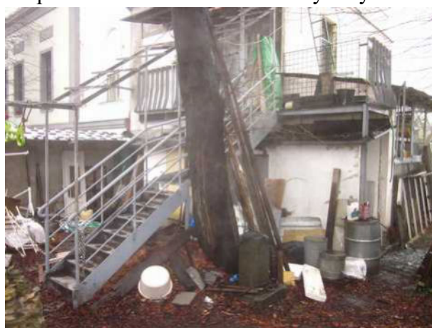
venkovní schodiště do bytu č. 22/4
