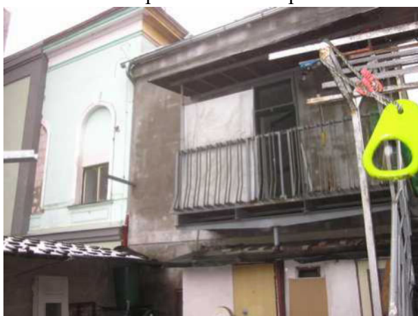
venkovní schodiště do bytu č. 22/4
