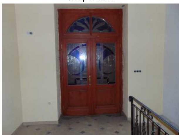
dveře z nebytového prostoru do ulice
