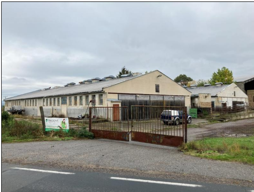
Obr. č. 1 Pohled z ulice Mikulovská na zemědělský areál v k. ú. Lednice na Moravě [zdroj: vlastní; místní šetření ze dne 9. 10. 2025]
