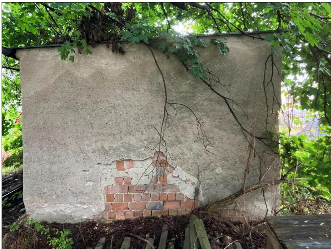
Obr. č. 43 Severovýchodní pohled na stavbu zemědělského areálu na pozemku p. č. 1560/35, k. ú. Lednice na Moravě [zdroj: vlastní; místní šetření ze dne 9. 10. 2025]
