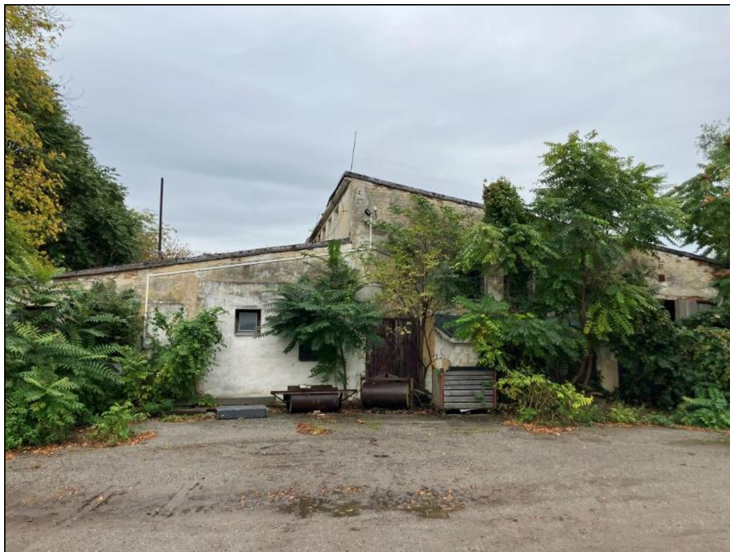
Obr. č. 36 Severozápadní pohled na halu zemědělského areálu na pozemku p. č. 1549/5, k. ú. Lednice na Moravě [zdroj: vlastní; místní šetření ze dne 9. 10. 2025]
