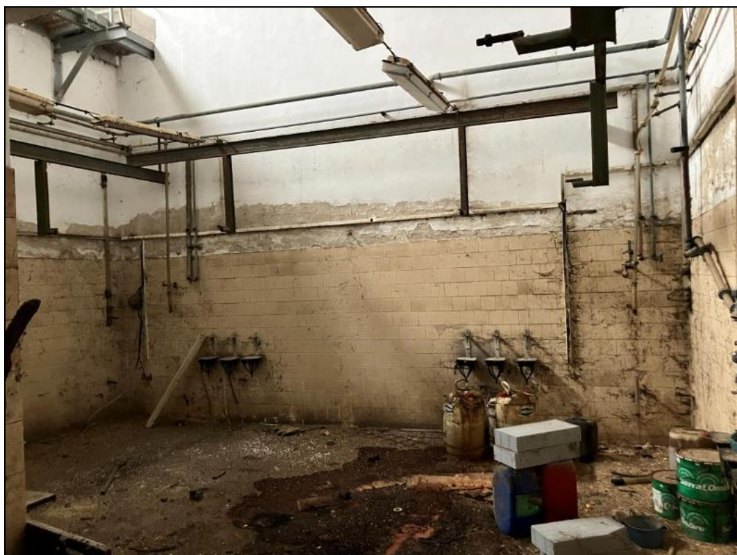
Obr. č. 24 Interiér haly (provozní místnost) zemědělského areálu na pozemku p. č. 1560/21, k. ú. Lednice na Moravě [zdroj: vlastní; místní šetření ze dne 9. 10. 2025]
