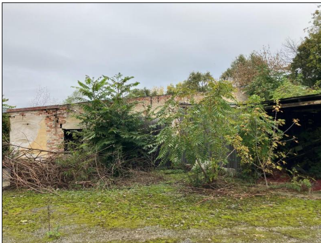
Obr. č. 38 Jihovýchodní pohled na halu zemědělského areálu na pozemku p. č. 1549/5, k. ú. Lednice na Moravě [zdroj: vlastní; místní šetření ze dne 9. 10. 2025]
