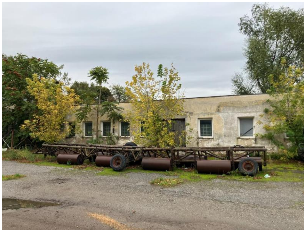
Obr. č. 35 Západní pohled na halu (spojovací stavba) zemědělského areálu na pozemku p. č. 1549/5, k. ú. Lednice na Moravě [zdroj: vlastní; místní šetření ze dne 9. 10. 2025]
