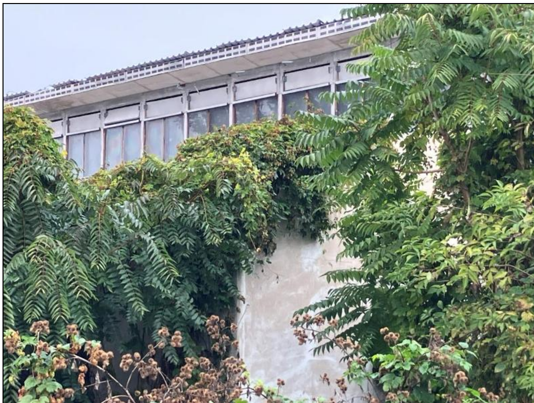
Obr. č. 21 Jižní pohled na halu zemědělského areálu na pozemku p. č. 1560/21, k. ú. Lednice na Moravě [zdroj: vlastní; místní šetření ze dne 9. 10. 2025]
