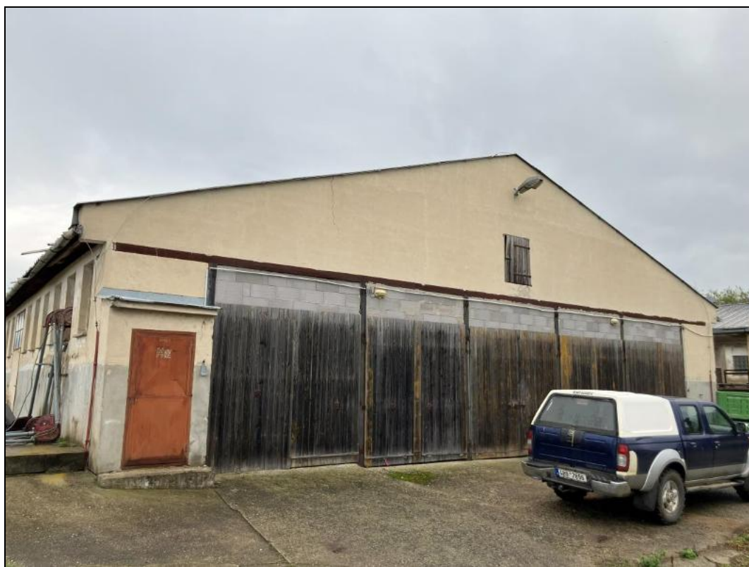
Obr. č. 2 Jihovýchodní pohled na halu zemědělského areálu na pozemku p. č. 1558/2, k. ú. Lednice na Moravě [zdroj: vlastní; místní šetření ze dne 9. 10. 2025]
