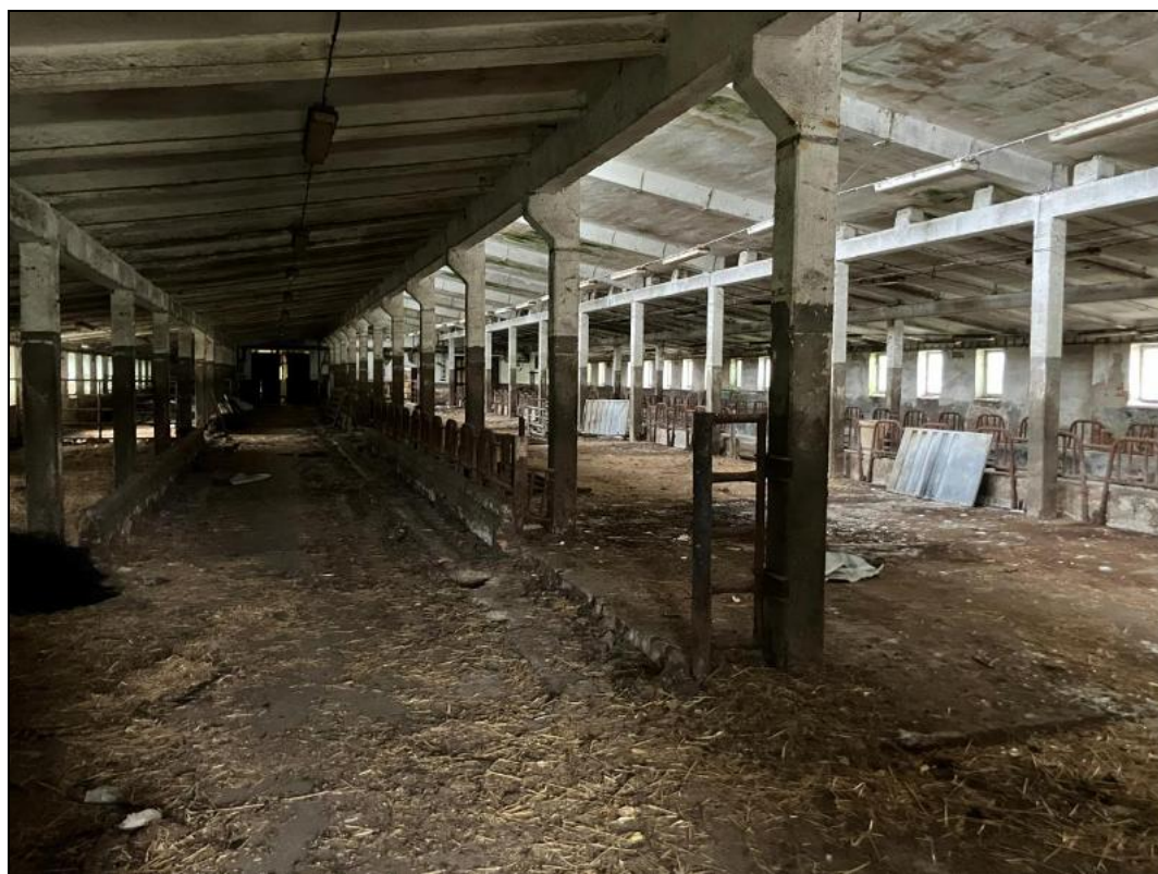
Obr. č. 32 Interiér haly (prostor haly) zemědělského areálu na pozemku p. č. 1549/4, k. ú. Lednice na Moravě [zdroj: vlastní; místní šetření ze dne 9. 10. 2025]
