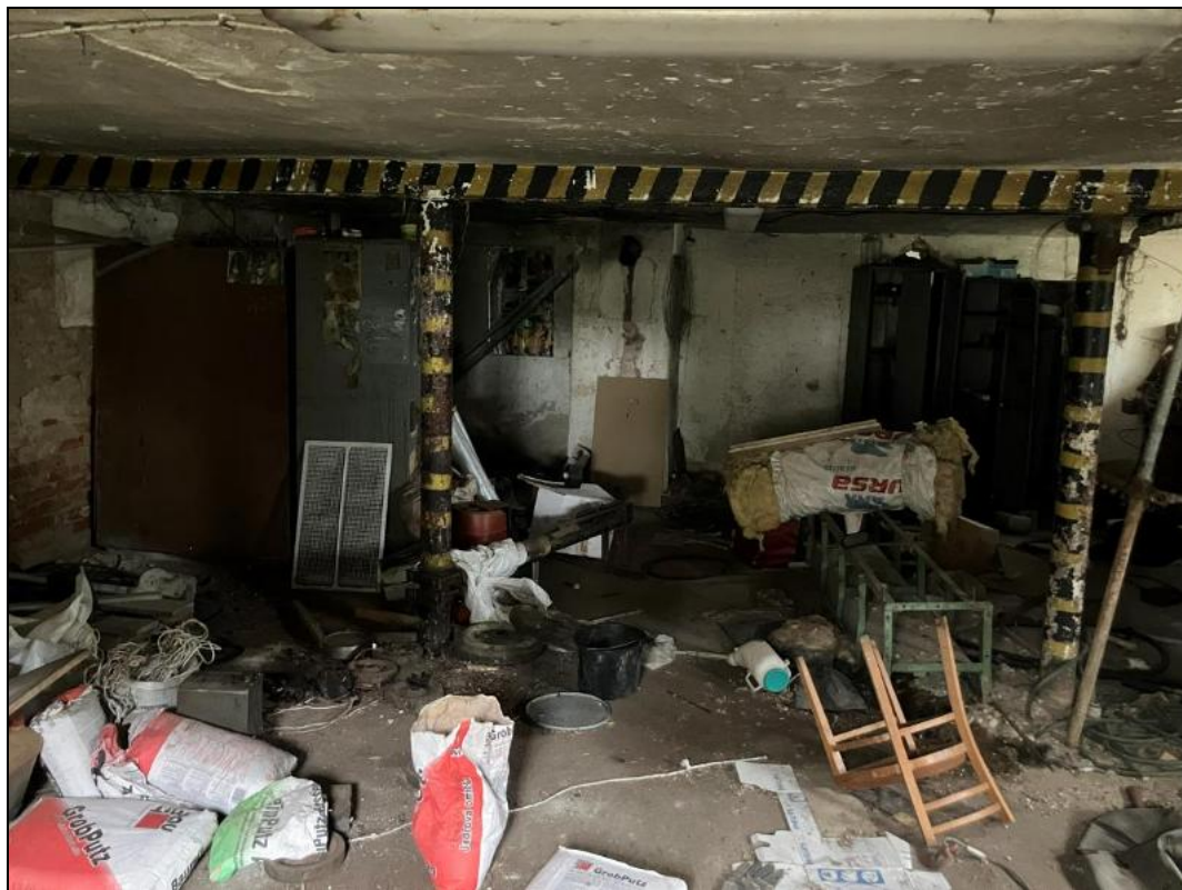
Obr. č. 17 Interiér haly (západní část) zemědělského areálu na pozemku p. č. 1553, k. ú. Lednice na Moravě [zdroj: vlastní; místní šetření ze dne 9. 10. 2025]
