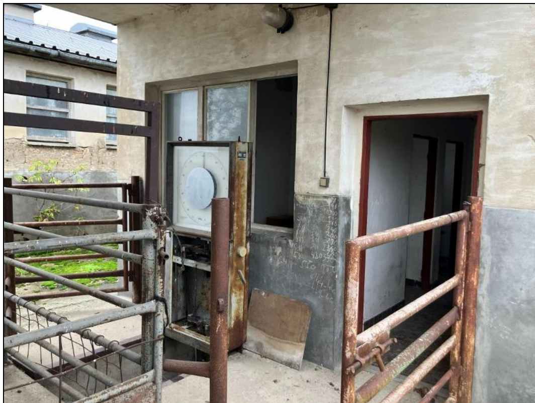
Obr. č. 49 Pohled do interiéru stavby vážního domku zemědělského areálu na pozemku p. č. 1560/44, k. ú. Lednice na Moravě [zdroj: vlastní; místní šetření ze dne 9. 10. 2025]
