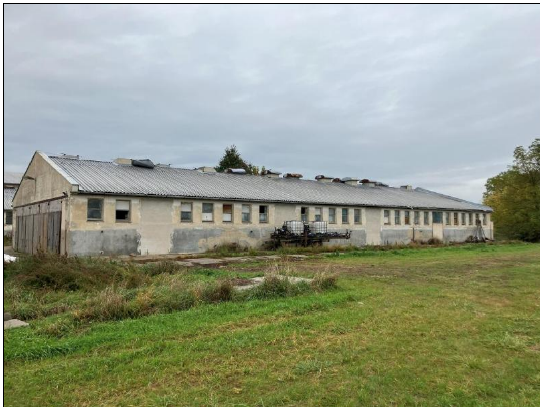
Obr. č. 3 Jihozápadní pohled na halu zemědělského areálu na pozemku p. č. 1558/2, k. ú. Lednice na Moravě [zdroj: vlastní; místní šetření ze dne 9. 10. 2025]
