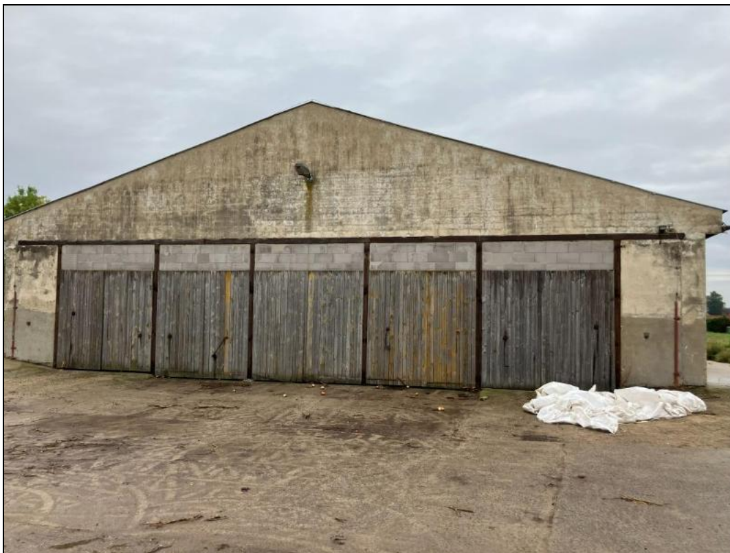
Obr. č. 4 Severozápadní pohled na halu zemědělského areálu na pozemku p. č. 1558/2, k. ú. Lednice na Moravě [zdroj: vlastní; místní šetření ze dne 9. 10. 2025]
