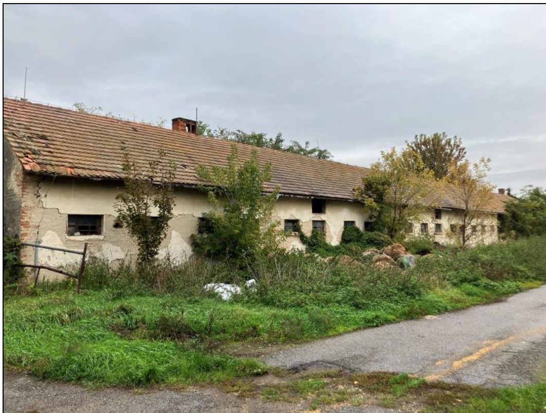
Obr. č. 15 Jihozápadní pohled na halu zemědělského areálu na pozemku p. č. 1553, k. ú. Lednice na Moravě [zdroj: vlastní; místní šetření ze dne 9. 10. 2025]
