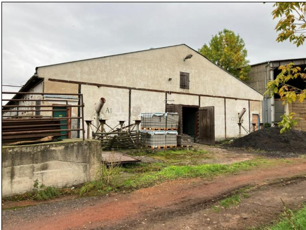
Obr. č. 7 Jihovýchodní pohled na halu zemědělského areálu na pozemku p. č. 1557/2, k. ú. Lednice na Moravě [zdroj: vlastní; místní šetření ze dne 9. 10. 2025]
