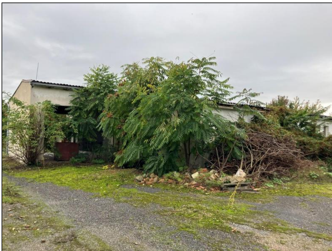
Obr. č. 30 Východní pohled na halu zemědělského areálu na pozemku p. č. 1549/4, k. ú. Lednice na Moravě [zdroj: vlastní; místní šetření ze dne 9. 10. 2025]
