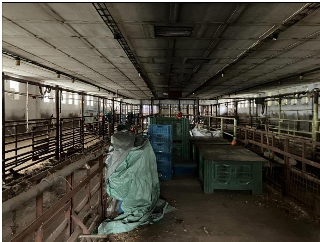
Obr. č. 6 Interiér haly zemědělského areálu na pozemku p. č. 1558/2, k. ú. Lednice na Moravě [zdroj: vlastní; místní šetření ze dne 9. 10. 2025]
