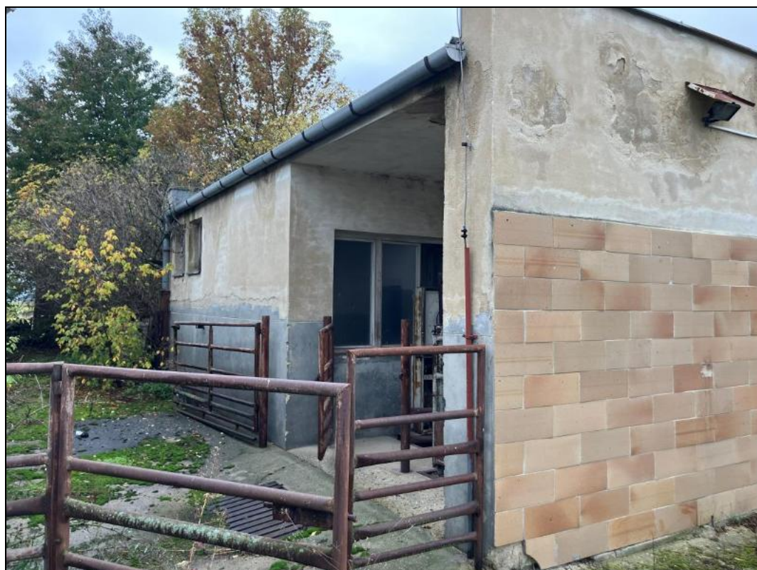
Obr. č. 48 Jižní pohled na stavbu vážního domku zemědělského areálu na pozemku p. č. 1560/44, k. ú. Lednice na Moravě [zdroj: vlastní; místní šetření ze dne 9. 10. 2025]
