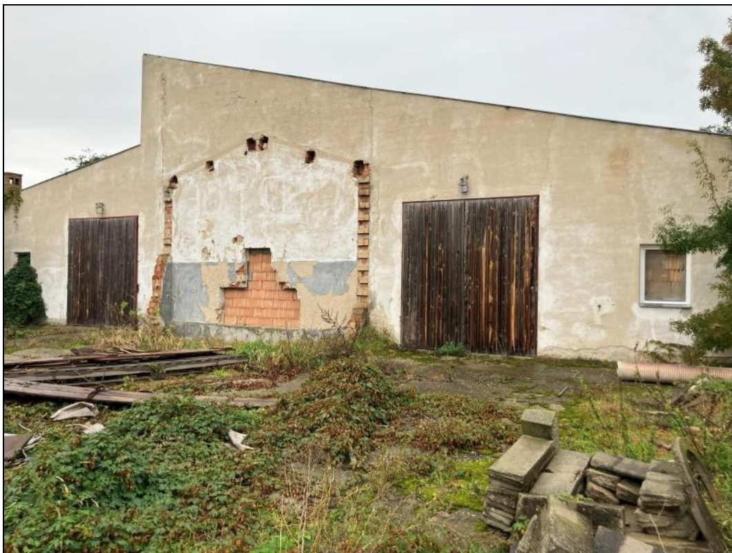
Obr. č. 19 Východní pohled na halu zemědělského areálu na pozemku p. č. 1560/21, k. ú. Lednice na Moravě [zdroj: vlastní; místní šetření ze dne 9. 10. 2025]
