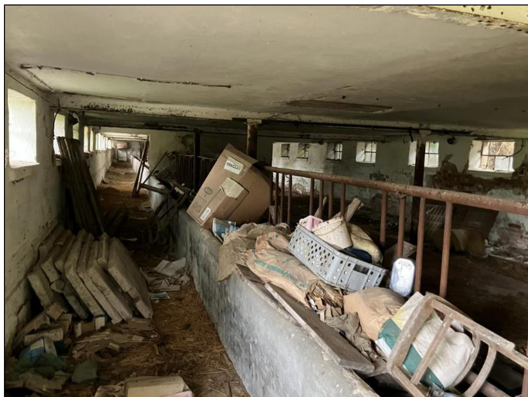
Obr. č. 18 Interiér haly (východní část) zemědělského areálu na pozemku p. č. 1553, k. ú. Lednice na Moravě [zdroj: vlastní; místní šetření ze dne 9. 10. 2025]
