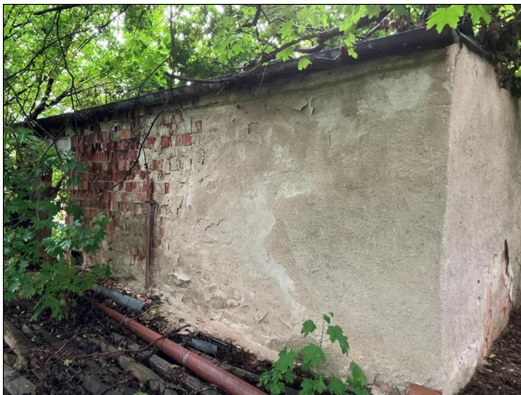
Obr. č. 44 Východní pohled na stavbu zemědělského areálu na pozemku p. č. 1560/35, k. ú. Lednice na Moravě [zdroj: vlastní; místní šetření ze dne 9. 10. 2025]
