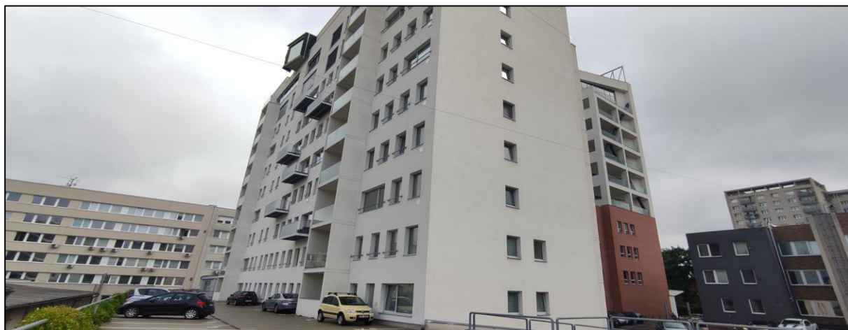
Obrázek č. 5 – Pohled na objekt ze dvora
