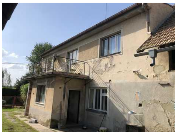
pohled V, obytná část
