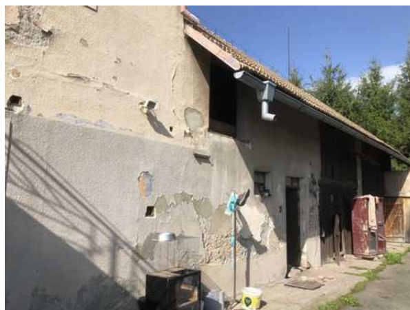
hosp. část, pohled JZ
