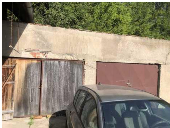
garáž, pohled ze dvora
