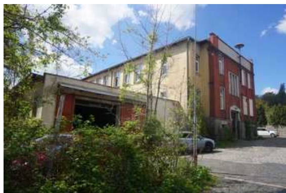
pohled od severovýchodu
