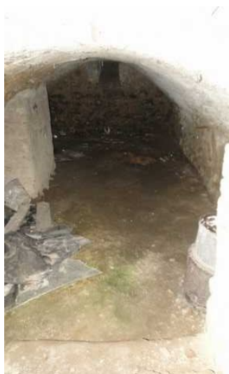
Klenutý sklep pod stodolou I.
