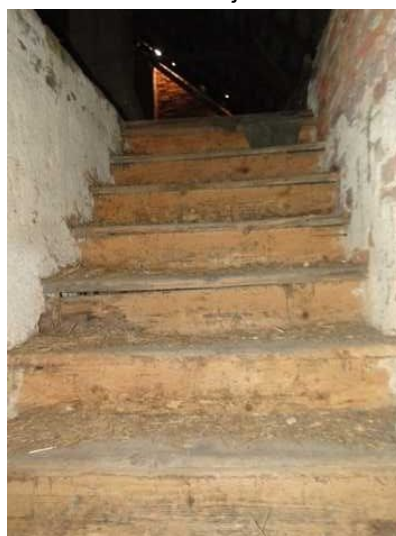
Schodiště na půdu
