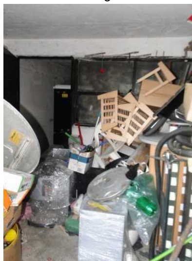
Interiér garáží (garáž v části s prosklenou příčkou)
