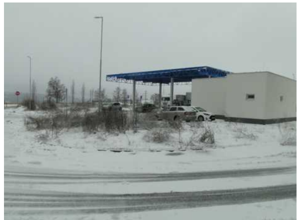
Okolí čerpací stanice
