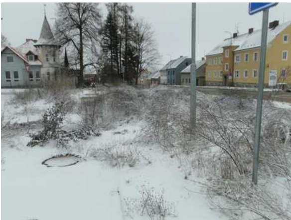
Okolí čerpací stanice
