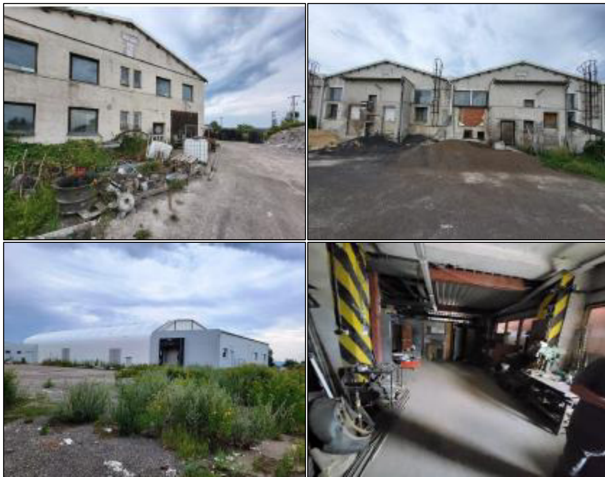
Obrázek č. 5 – Srovnávací vzorek č. 1 – výrobně-skladový areál
