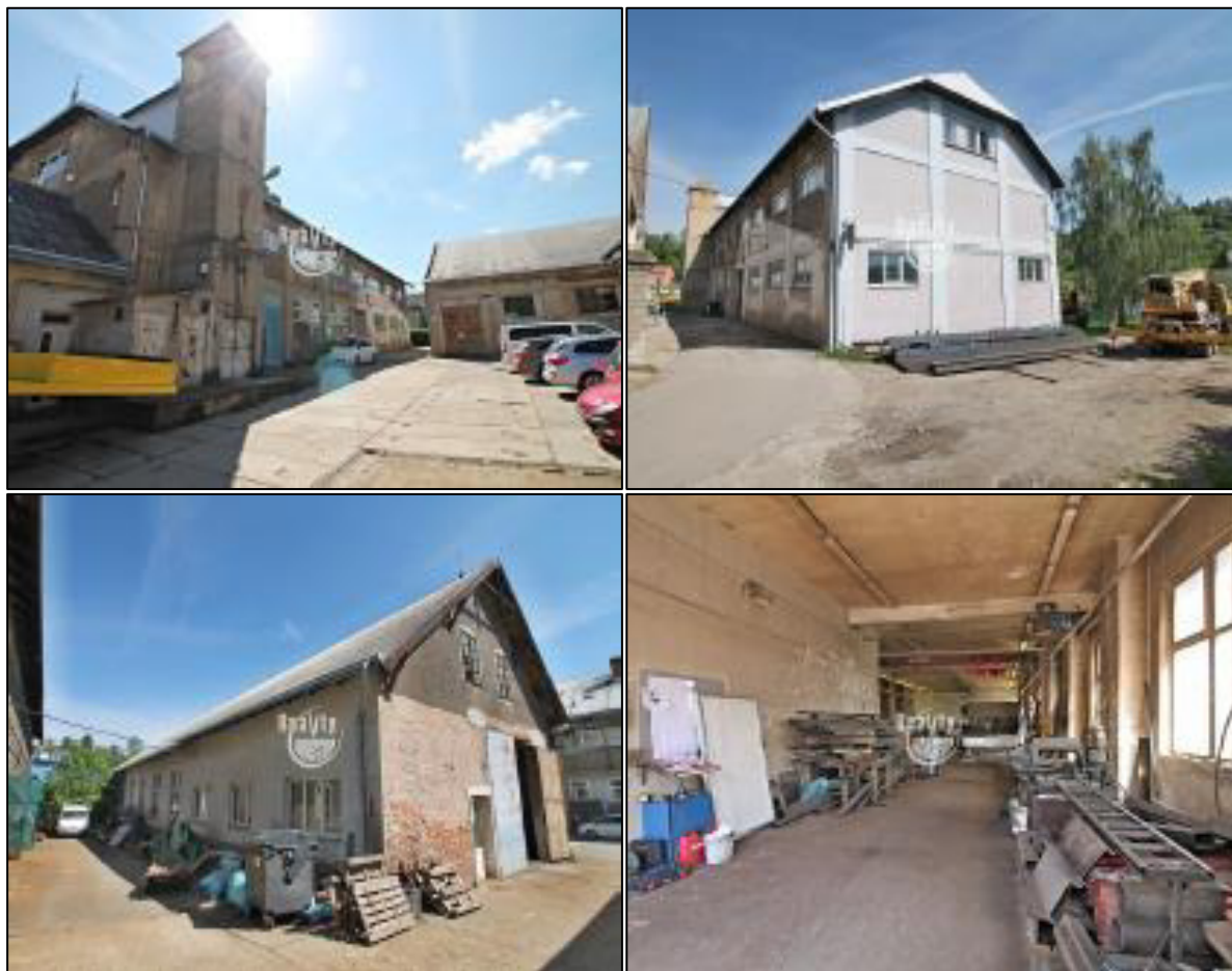
Obrázek č. 6 – Srovnávací vzorek č. 2 – výrobně-skladový areál
