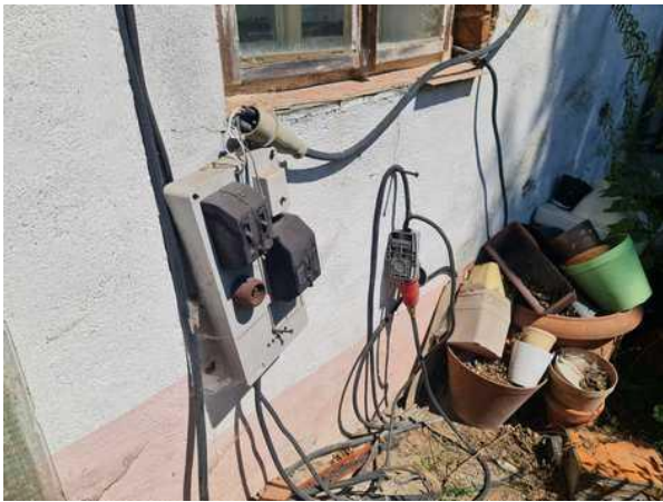
přivedení elektro vnitřním kabelem z pilíře na sousedním pozemku jiného vlastníka
