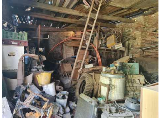
poškozená hospodářská část
