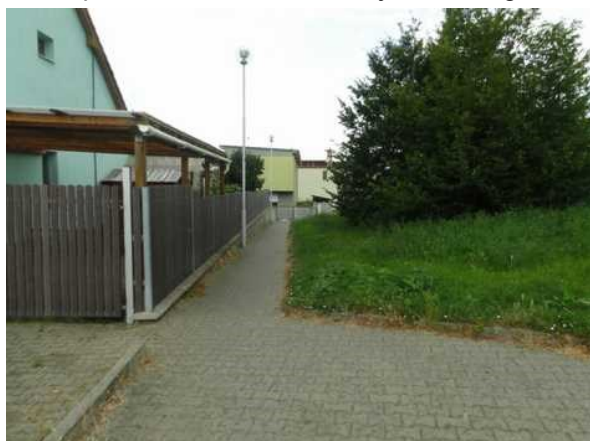
Přístup k víceúčelové stavbě od bytového domu
