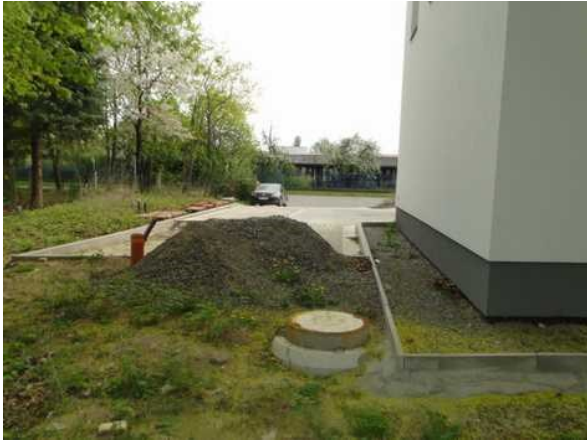
Okolí čerpací stanice
