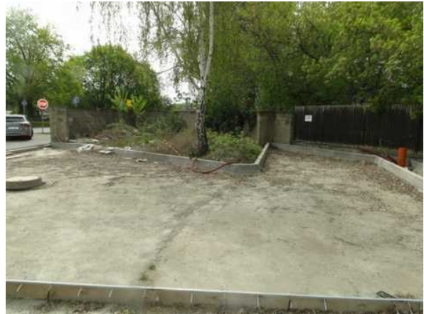
Okolí čerpací stanice
