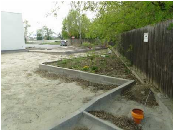
Okolí čerpací stanice
