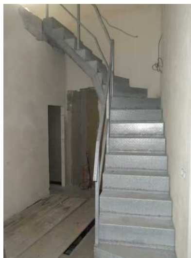
Schodiště do 2.NP
