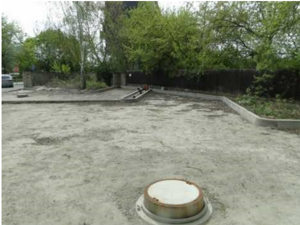
Okolí čerpací stanice
