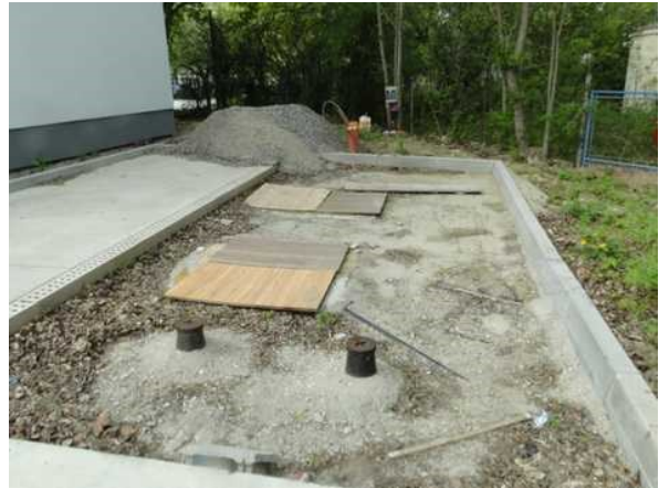
Okolí čerpací stanice
