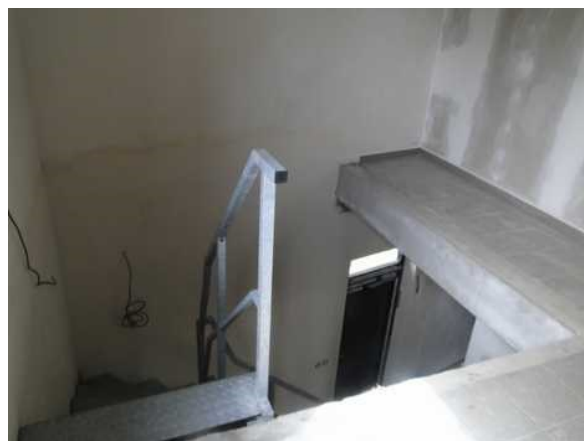
Schodiště s podestou ve 2.NP
