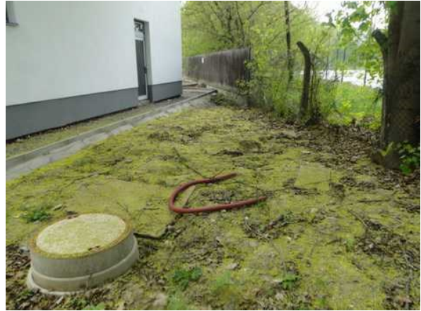
Okolí čerpací stanice
