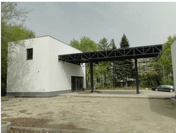
Kiosek s přístřeškem
